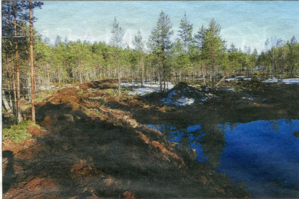
Jolkankydön pintavalutuskenttä, oikealla osa laskeutusallasta ja vasemmalla pintavalutuskentän vasen reunavalli.
